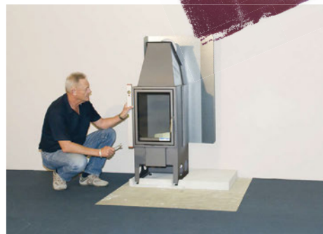
Osadte krbovú vložku pomocou vodováhy. (3)
