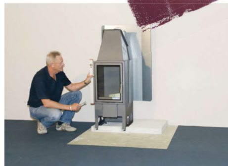
Osadte krbovú vložku pomocou vodováhy. (3)
